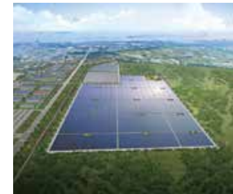
새만금 육상태양광 1구역(99MW)
