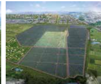
새만금 육상태양광 2-1구역(49.5MW)
