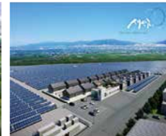
새만금 육상태양광 3구역(99MW)
